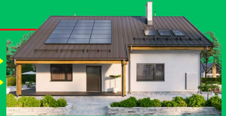
Hệ Solar 10.44 KWp
